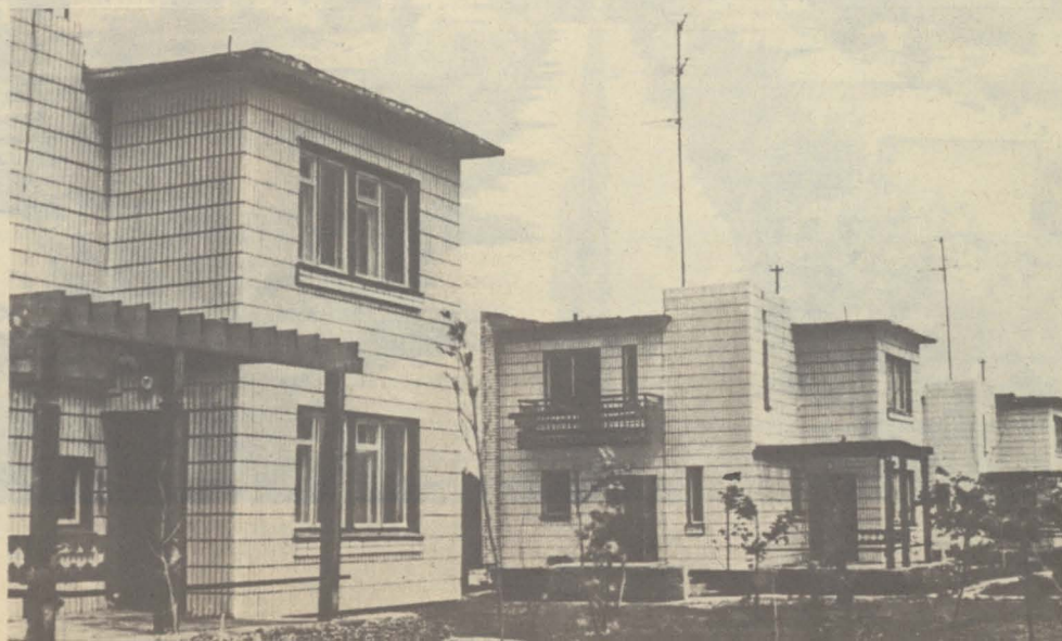
В белорусском поселке Заширь идет строительство таких двухэтажных домиков. В них поселятся рабочие совхоза «Коммунист».
